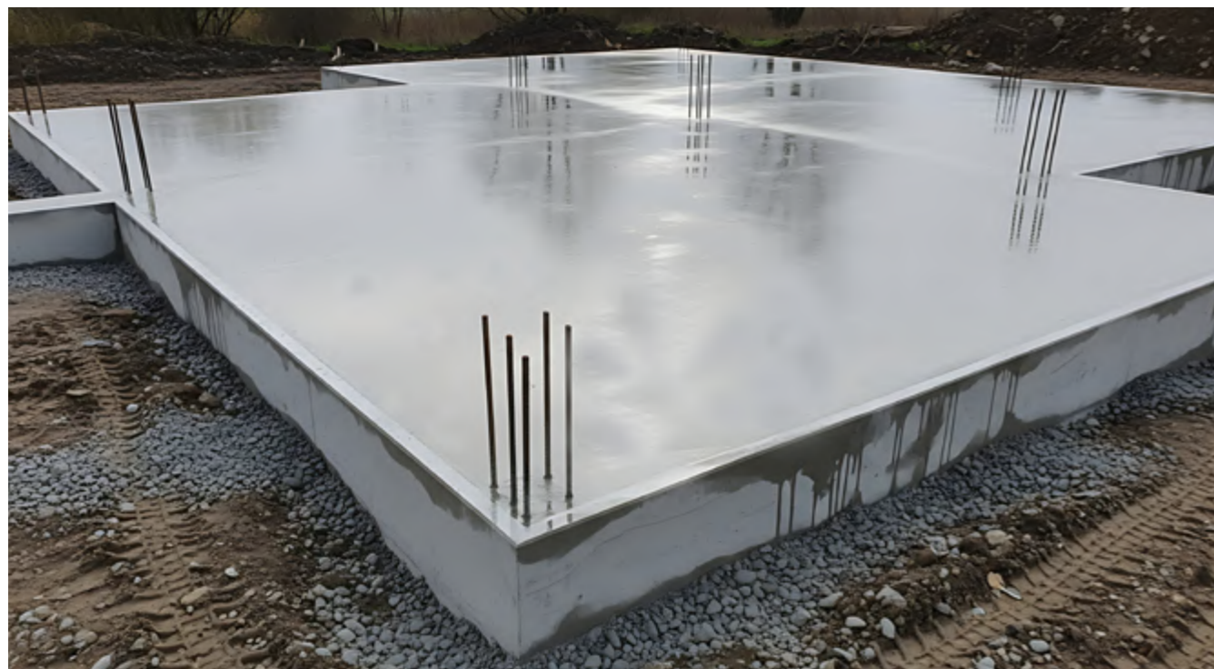
(e) Beton- und Maurerarbeiten
