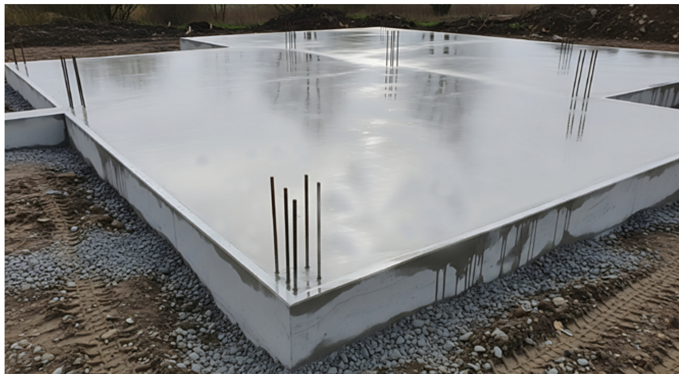
(e) Beton- und Maurerarbeiten
